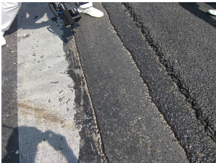
Рисунок 8. Трехслойная дорожная одежда на мосту. Слева видна сетка распределения давления (пароотводящая сетка) (фото авторов)
