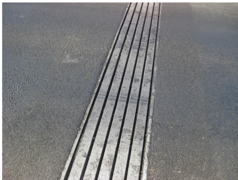
Рисунок 10. Сопряжение дорожной одежды с деформационным швом (через переходной участок) (фото авторов)
