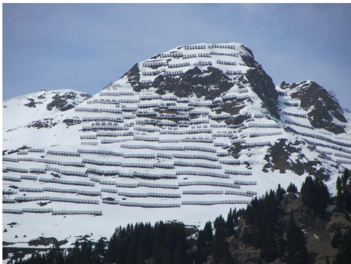
Рисунок 1. Застройка склона снегоудерживающими сооружениями ( https://pxhere.com/en/photo/1127905 Дата обращения 19.10.2023)
