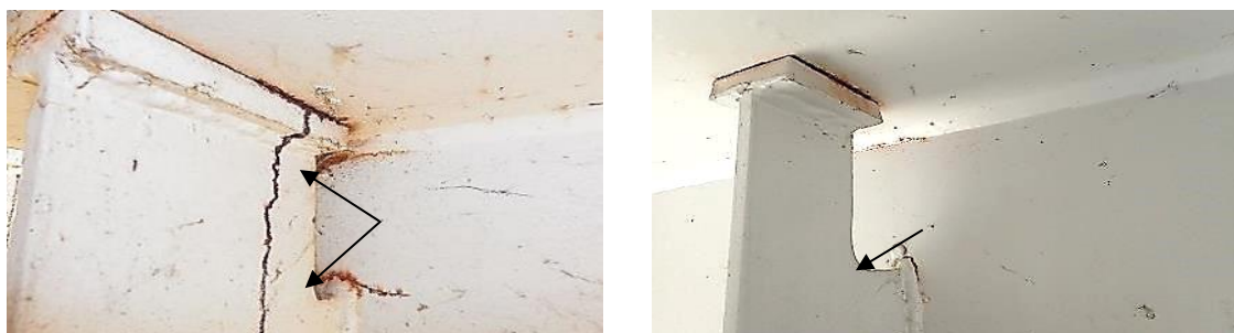
Рисунок 2. Трещины в автодорожных мостах у верхних концов сварных швов (фото авторов)
