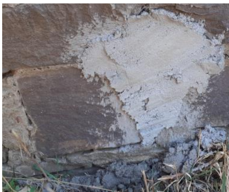
Рисунок 6. Ремонт участка каменной кладки подпорной стены битумоцементобетоном (фото авторов)
