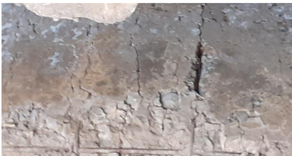
Рисунок 2. Разрушения плит ездового полотна (фото авторов) Figure 2. Bridge floor deck destruction (photo by the authors)
