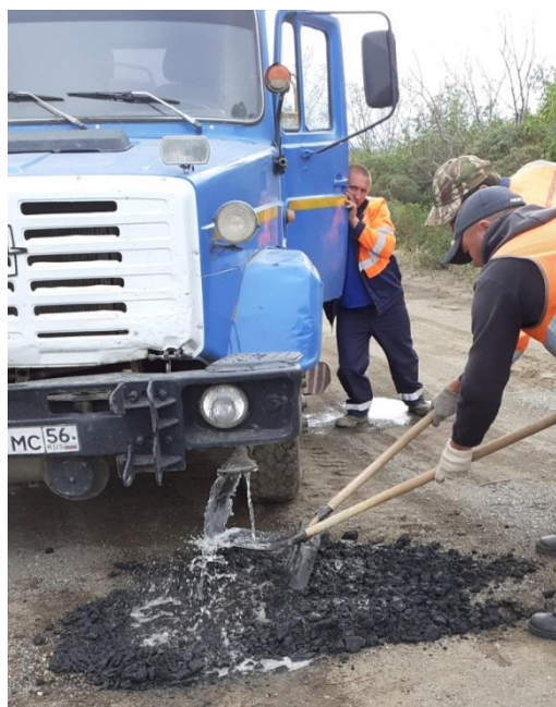
Рисунок 7. Ремонт выбоин битумной суспензией (фото авторов) Figure 7. Depression repair with bituminous slurry (photo by the authors)
