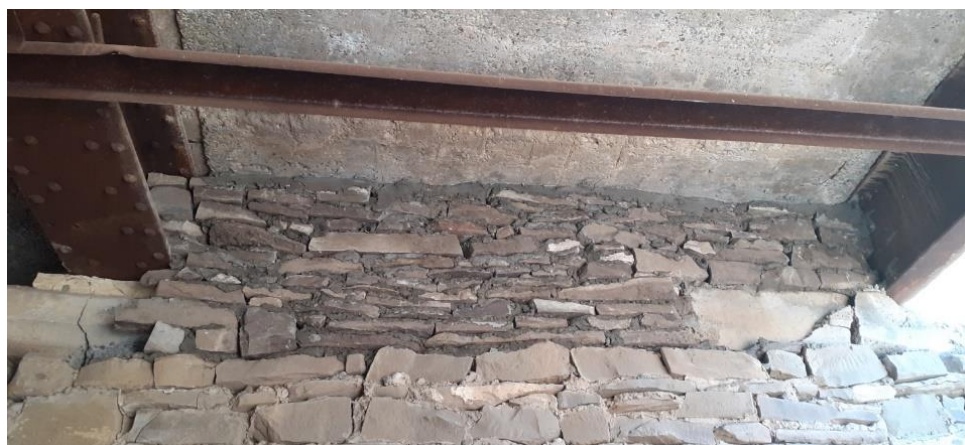
Рисунок 4. Укрепление плит каменной кладкой с применением цементного раствора с битумной суспензией (фото авторов)
