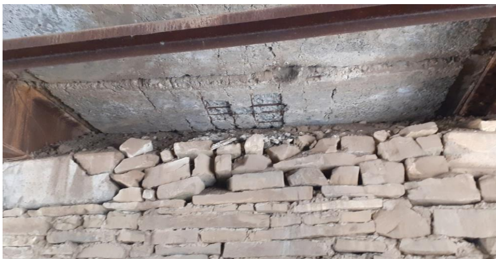
Рисунок 1. Разрушения опорных элементов малого моста (фото авторов) Figure 1. Bearing elements destruction of the minor bridge (photo by the authors)
