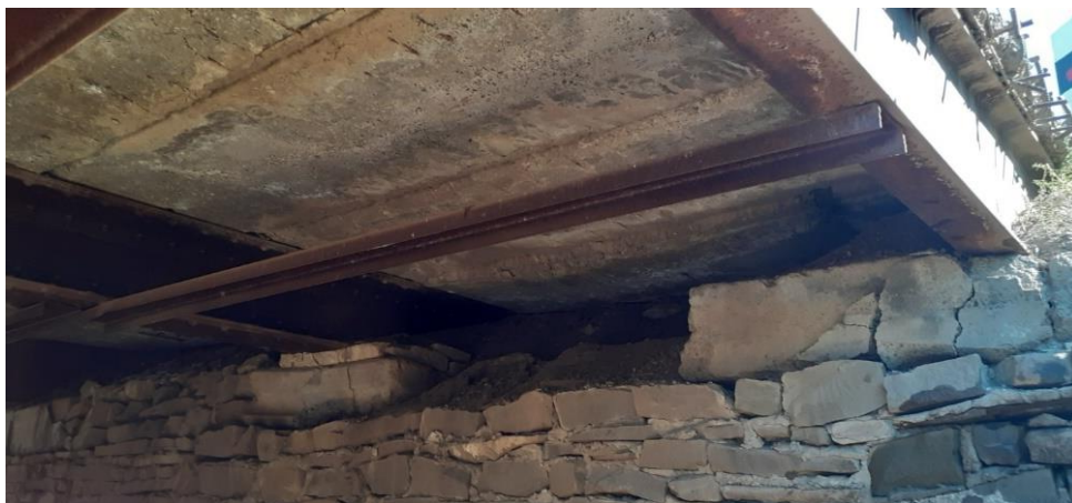
Рисунок 1. Разрушения опорных элементов малого моста (фото авторов) Figure 1. Bearing elements destruction of the minor bridge (photo by the authors)
