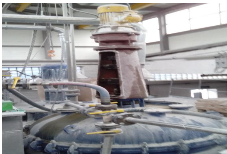
Рисунок 6. Установка окончательного перемешивания (фото автора)
