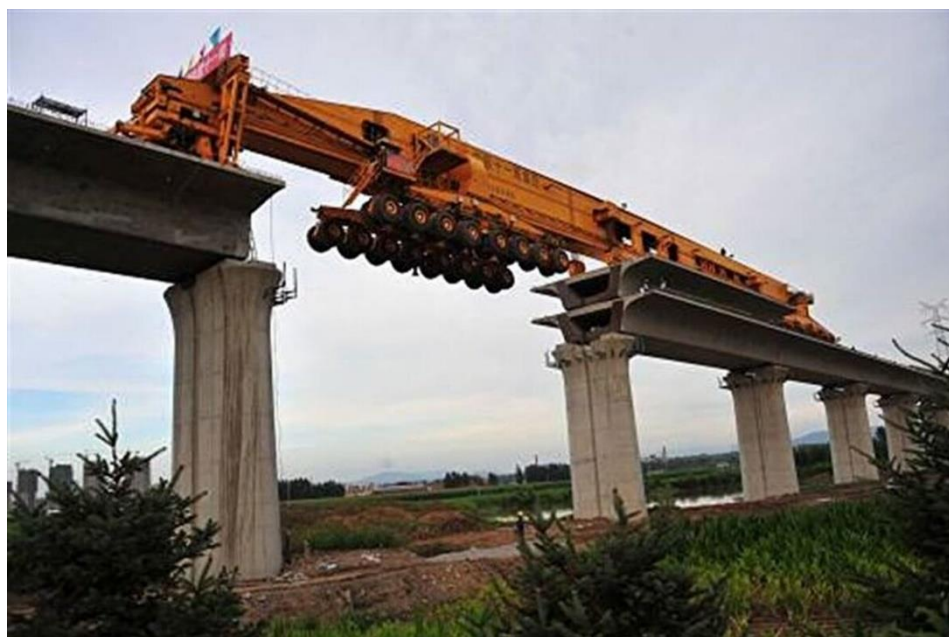
Рисунок 10. Надвижка пролетного строения (источник: https://www.techeblog.com/slj900-32-is-the-massive-580-ton-machine-they-use-to-build-bridges-these-videos-show-how/ Автор: Jackson Chung)
