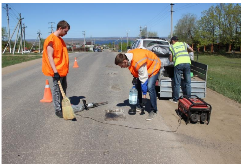
Рисунок 4. Предварительное увлажнение водой карты ремонта (фото авторов)
