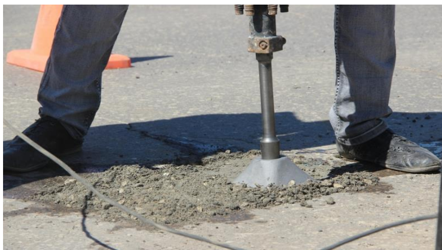
Рисунок 7. Уплотнение ремонтной смеси (фото авторов)
