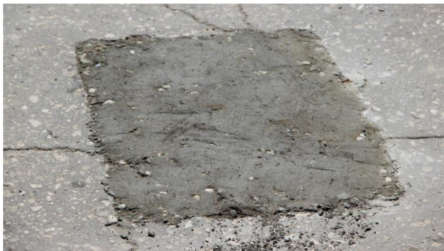
Рисунок 8. Результат ремонта проезжей части картами (фото авторов)
