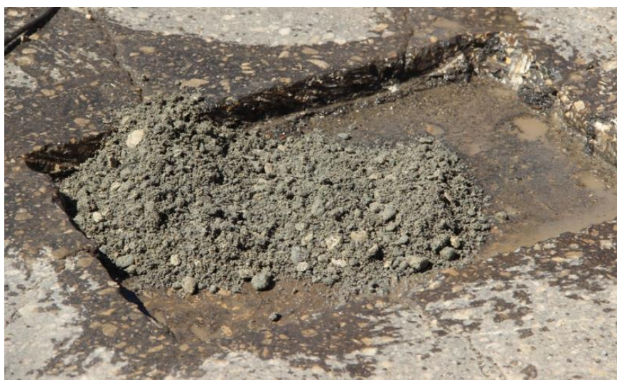
Рисунок 6. Распределение ремонтной смеси в карте (фото авторов)
