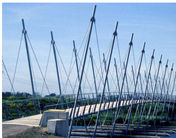
Рисунок 10. Мост «тенсегрити» в Пурмеренде, Нидерланды.
