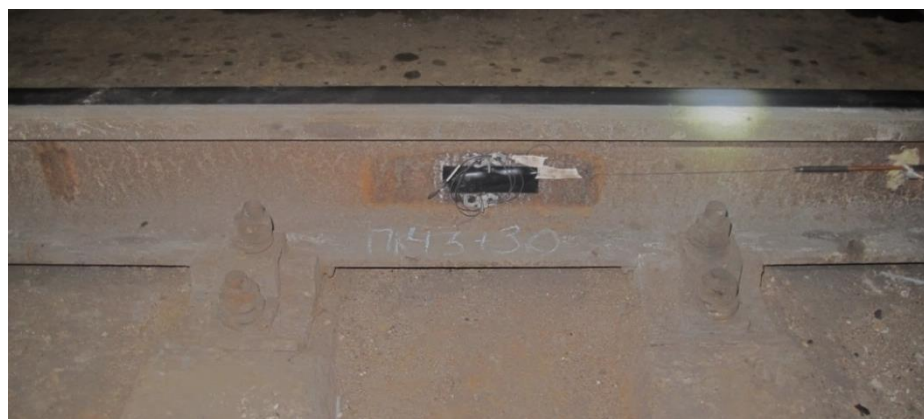
Рис. 3. Датчик os3200 на рельсе [Sensor os3200 on the rail]
