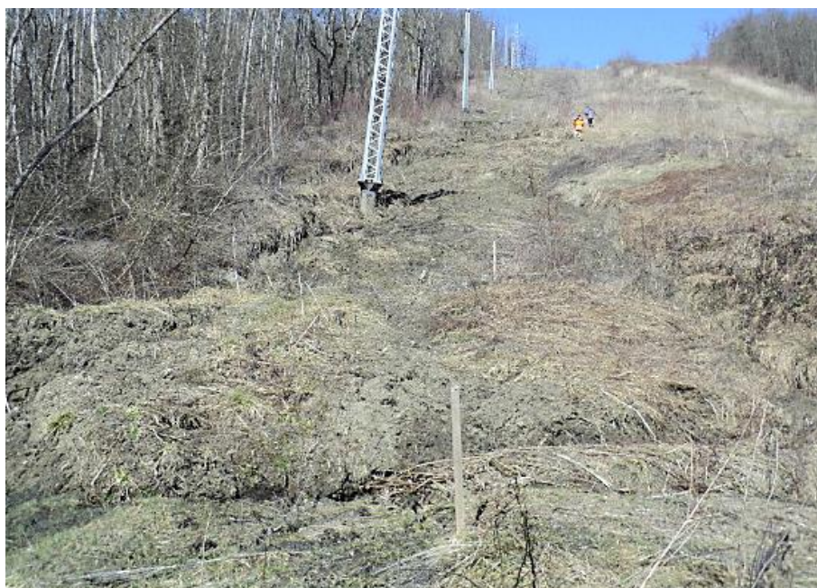
Рисунок 1. Общий вид склона с бровками срыва (разработано автором) Figure 1. Slope general view with road edge breakaways (developed by the author)
