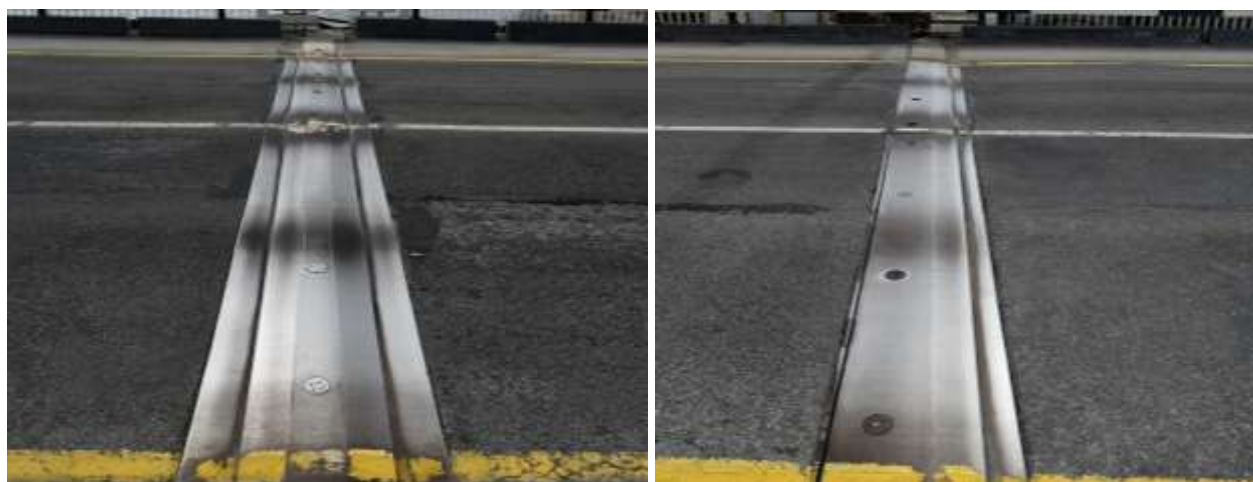
Рисунок 2. Деформационные швы перекрытого типа (разработано авторами)
