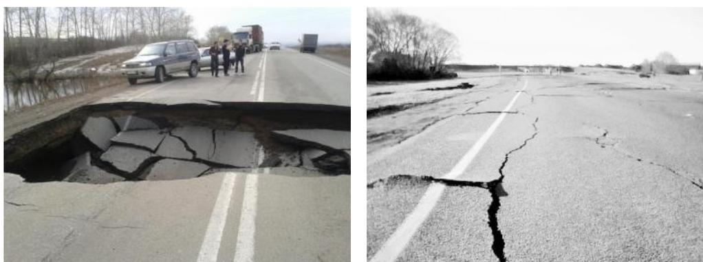
*Рис.1. Разрушение земляного полотна
