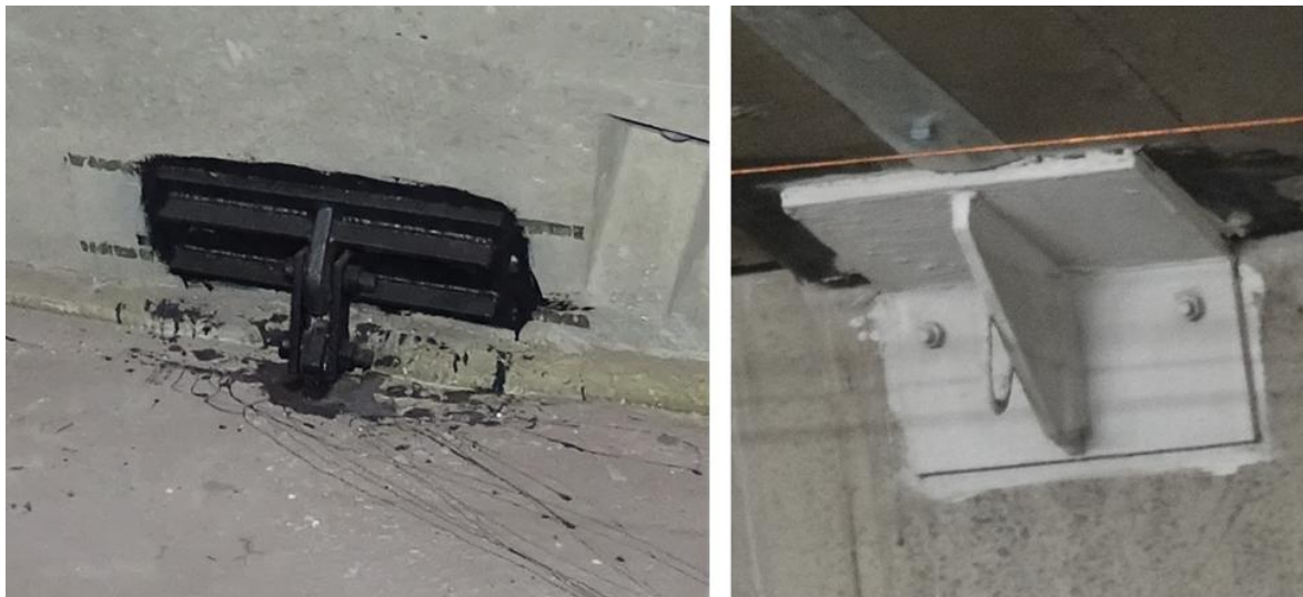
Рисунок 6. Общий вид закрепления плиты по краю с помощью подвеса; общий вид опорного столика (фото автора)
