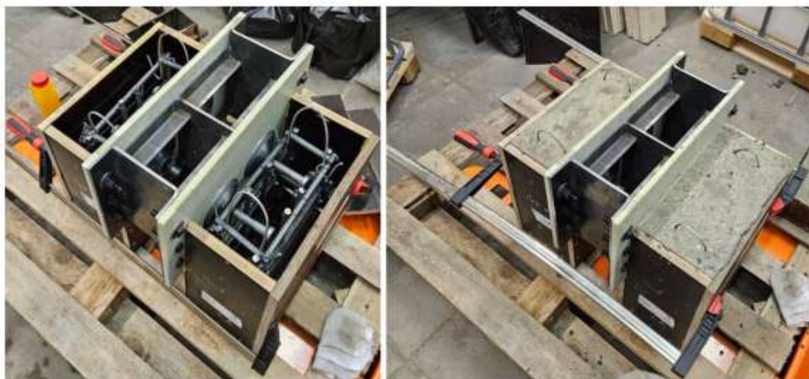
Рисунок 13. Бетонирование образца (разработано авторами)
