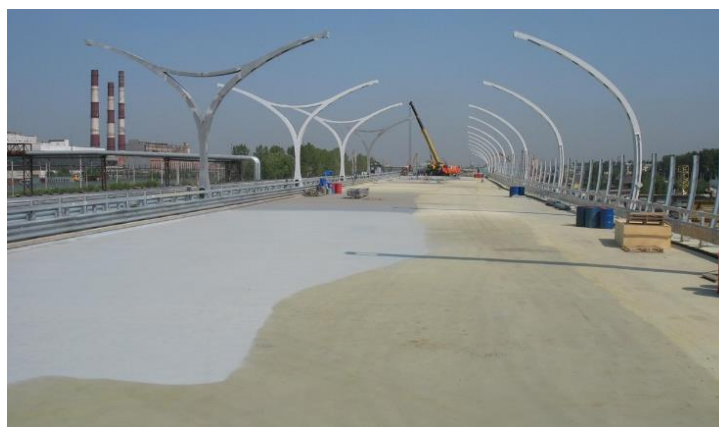
Рисунок 2. Применение напыляемых полимерных материалов для гидроизоляции мостовых сооружений на западном скоростном диаметре г. Санкт-Петербурга (фото ООО НПФ «Современные покрытия», г. Санкт-Петербург)
