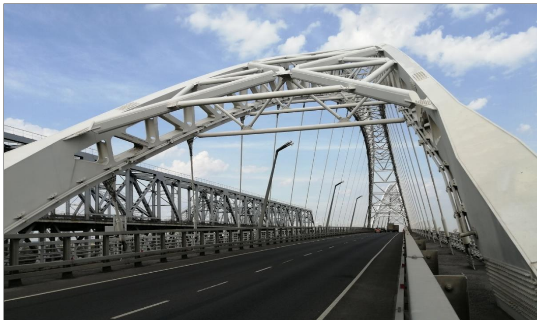
Рисунок 1. Арочные пролетные строения мостового перехода (фото авторов)
