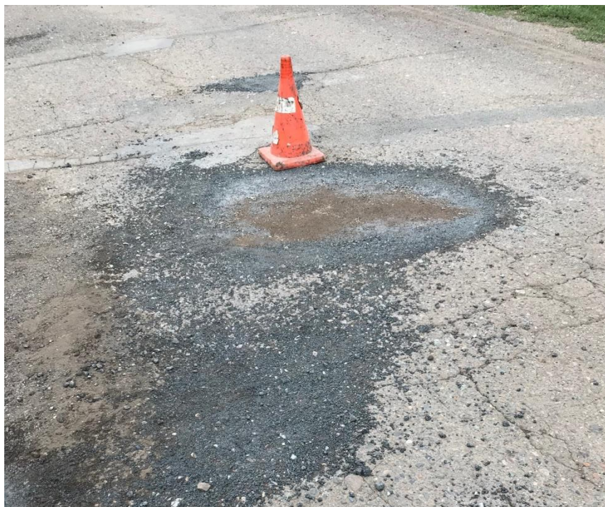
Рисунок 5. Результат ремонта ямы ремонтной асфальтобетонной смесью (уплотнение виброплитой) (рисунок авторов)
