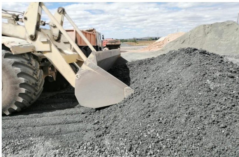
Рисунок 2. Отбор холодной влажной асфальтобетонной смеси с дисперсным вязким битумом (аналог Б2) из бурта хранения (рисунок авторов)
