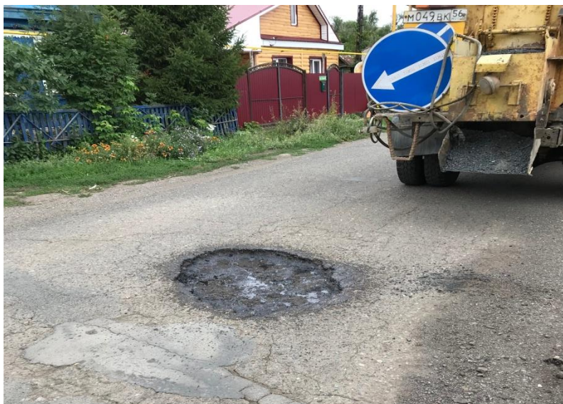
Рисунок 3. Подготовка ямы перед заполнением ремонтной асфальтобетонной смесью (рисунок авторов)
