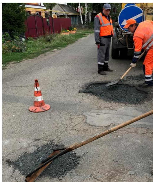
Рисунок 4. Заполнение ямы ремонтной асфальтобетонной смесью (рисунок авторов)
