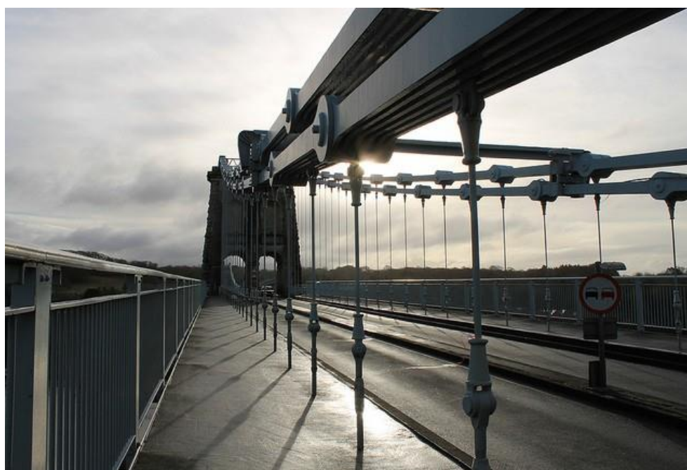
Рисунок 3. Современный вид проезжей части моста Менай (источник: http://phototravelguide.ru/most/most-menai/ )
