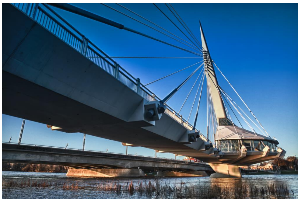
Рисунок 7. Пешеходный мост Esplanade Riel Pedestrian Bridge. Вид снизу (источник: https://en.wikipedia.org/wiki/Esplanade_Riel )
